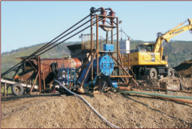
Instalación para la recuperación de oro fina de relaves, Zabaikalie
